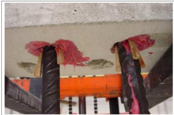
圖10 使用楔型木片固定鋼筋
